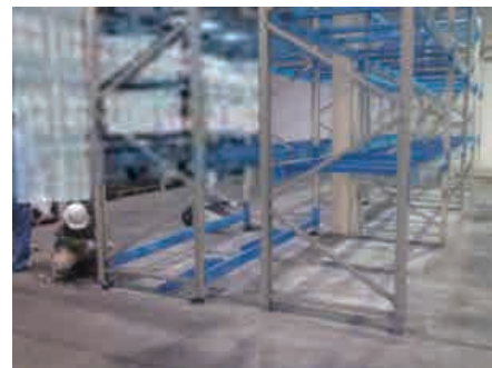
免震装置アンティシスモ施工作业
